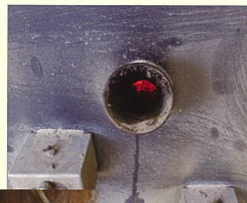
炉内で鶏ふんが燃焼している
